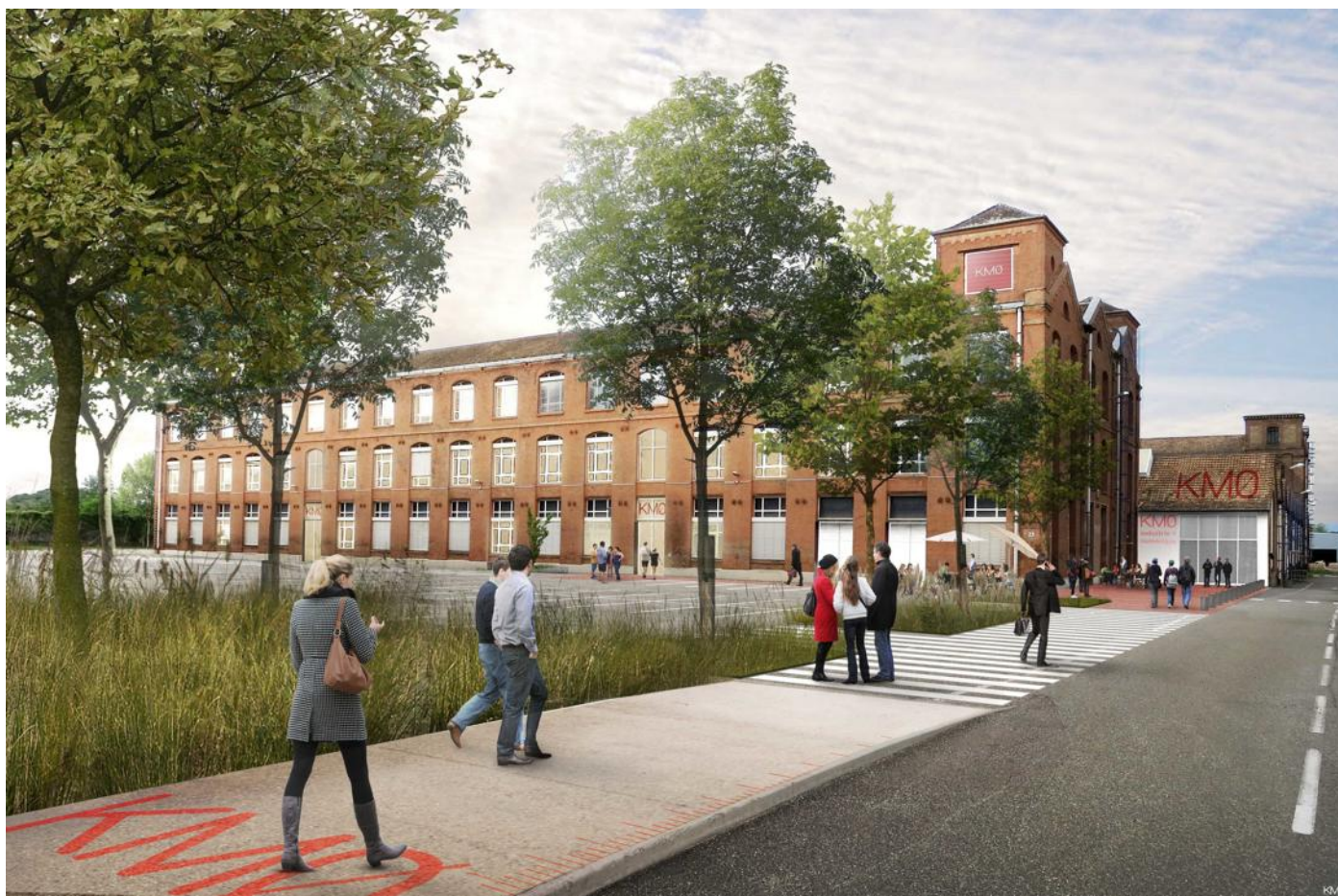
L'entrée de KMO se fera par ce parvis, à quelques dizaines de mètres de la Fonderie et des futurs lofts. DR DEA ARCHITECTES
