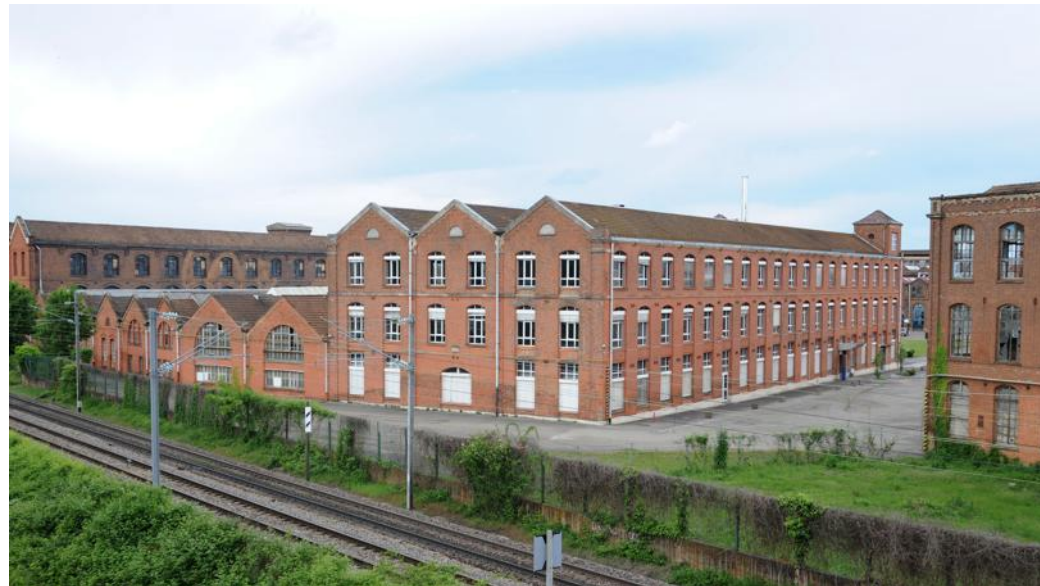
Les bâtiments du KMO : à droite les trois niveaux qui accueilleront formations et entreprises déjà existantes. A gauche, l'atelier avec le toit en shed qui accueillera notamment le « TechLab ». PHOTO DNA CATHY KOHLER
