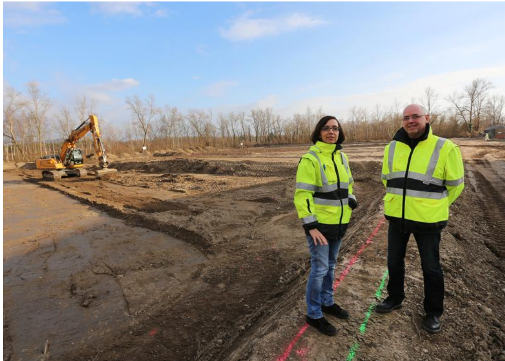
Elena Viviani, la directrice du site SCA de Kunheim, et Sylvain Tschaen, responsable du projet, sur le chantier de la future station biologique. PHOTO DNA-JLUC SYREN
