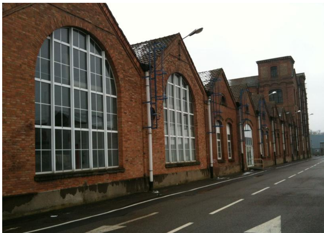
Les bâtiments qui vont abriter KMØ tels qu'ils se présentent actuellement. Les travaux de réhabilitation vont démarrer en avril et devraient durer une année. PHOTO DNA - FZ
